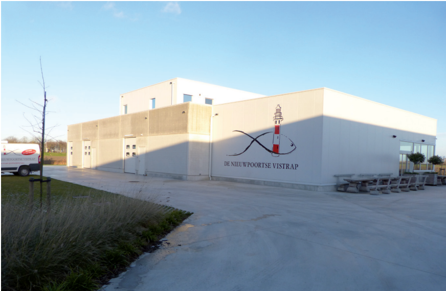
In februari verhuisde de Nieuwpoortse Vistrap van de Smokkelstraat naar een volledige nieuwbouw in de Ambachtstraat op de industriezone. Het concept winkel voor particulieren zonder koeltoogbanken blijft behouden.
